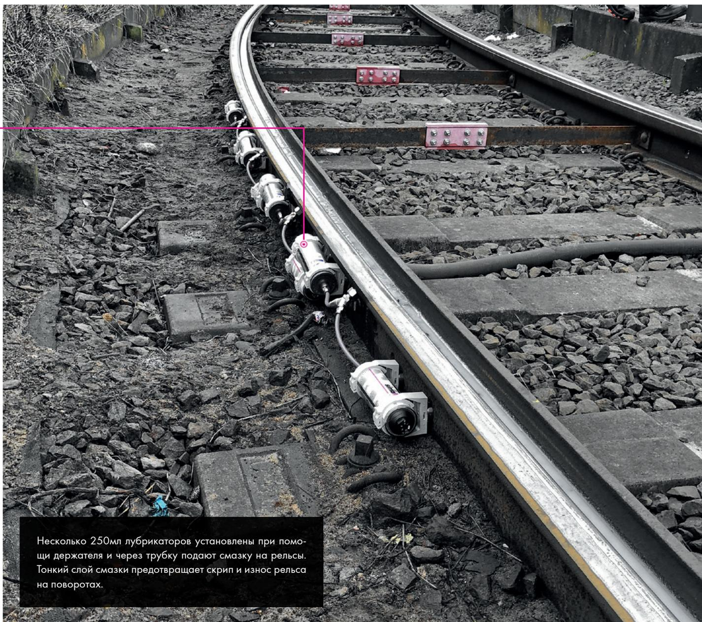
Несколько 250мл лубрикаторов установлены при помощи держателя и через трубку подают смазку на рельсы. Тонкий слой смазки предотвращает скрип и износ рельса на поворотах.
